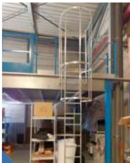
Accès occasionnel à l'étage par échelle crinoline.
