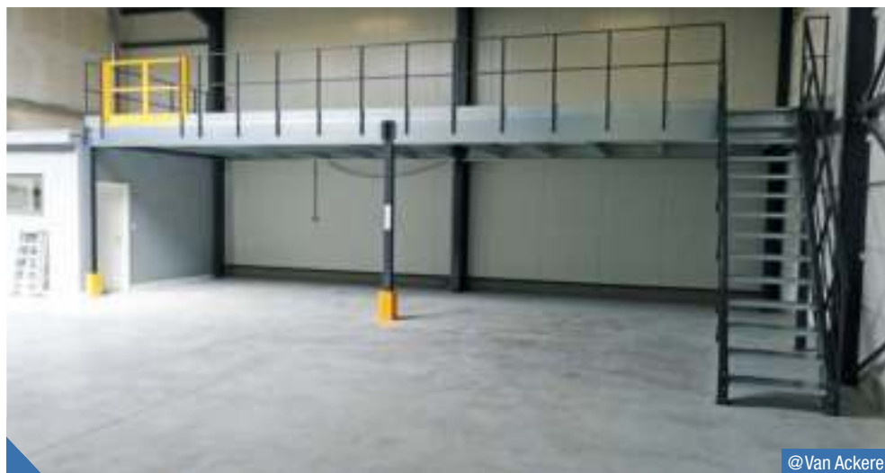
Installation de la structure plate-forme adaptée en continuité du bureau déjà en place.
